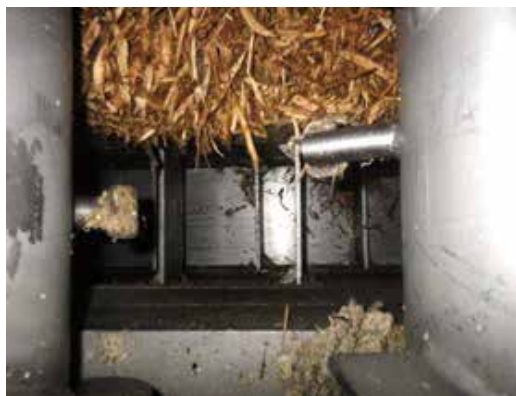
写真-13 搬送状況（1階コンベヤ）
