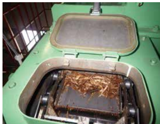
写真-14 搬送状況（3階コンベヤ）
