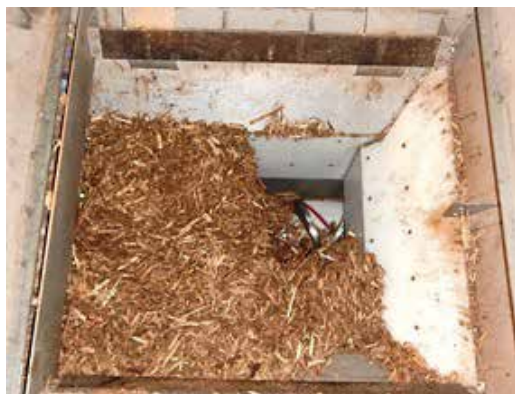
写真-11 ブリッジ発生状況
