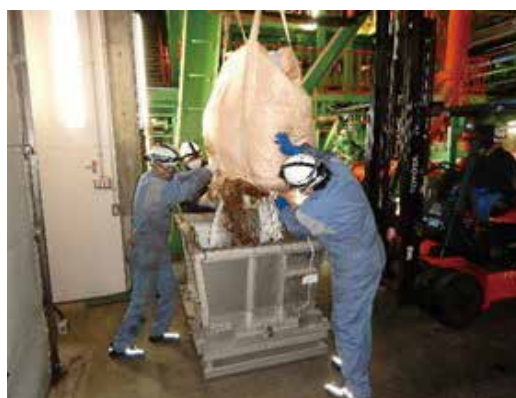
写真－5 フレコンバッグからの投入作業
