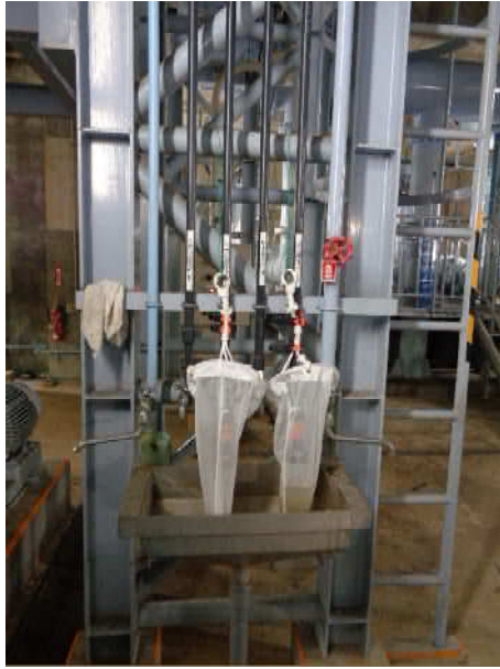
写真-3 プランクトンネット設置状況
