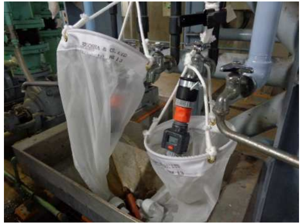
写真-4 水量メーター設置状況
