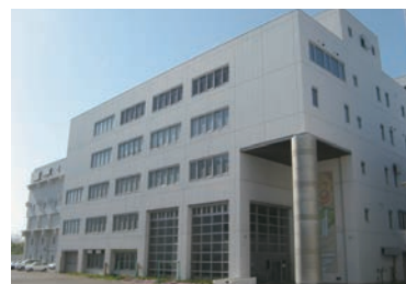
西部スラッジセンター脱水施設
