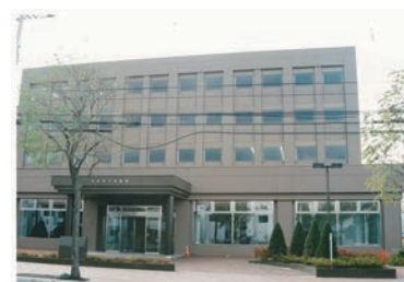
札幌市下水道局庁舎
