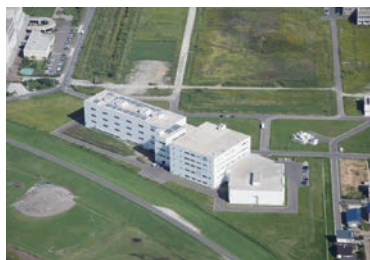
東部スラッジセンター
