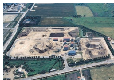
中沼路盤材リサイクルプラント
