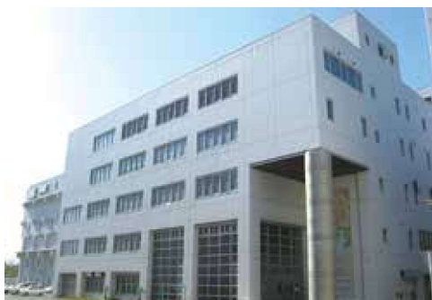
◀西部スラッジセンター脱水施設
