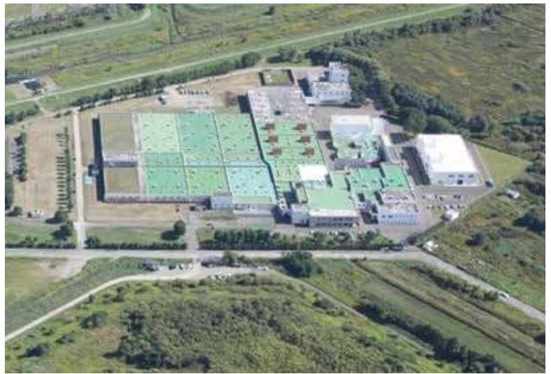
▲厚別水再生プラザ
