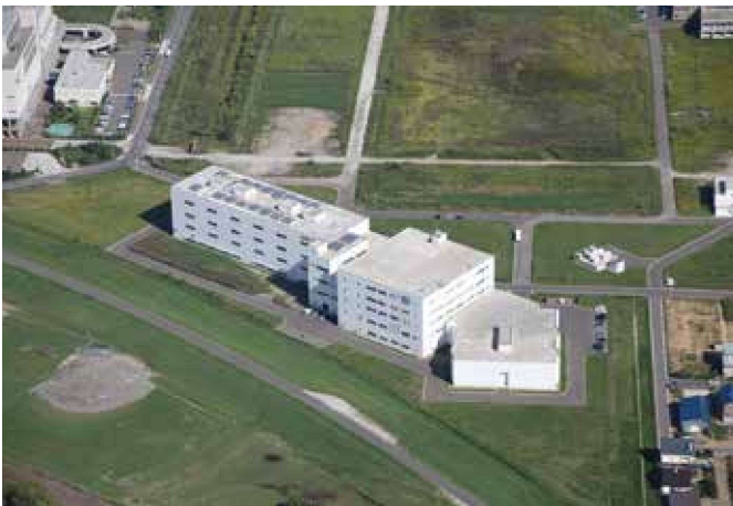
▲東部スラッジセンター
