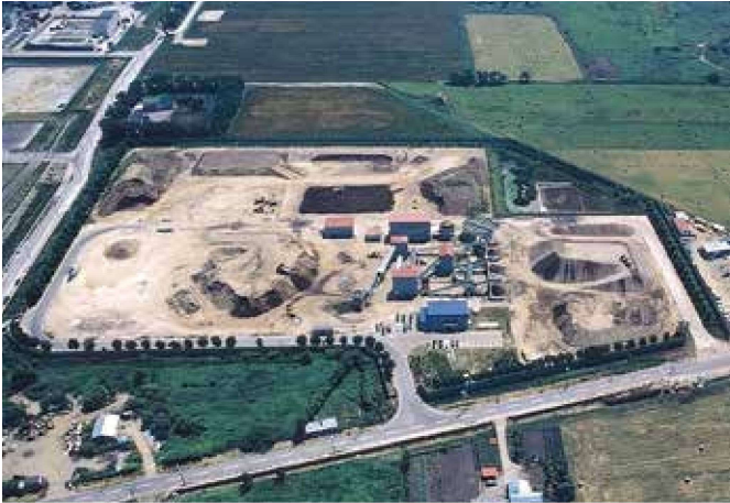
▲中沼路盤材リサイクルプラント
