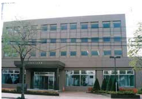
◀札幌市下水道局庁舎
