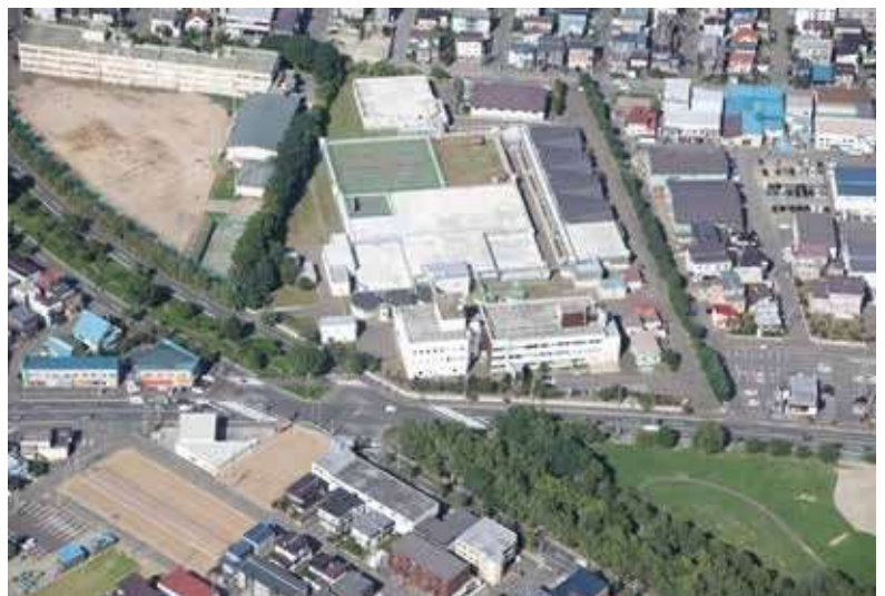
▲伏古川水再生プラザ
