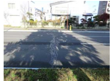
写真-2 ひびわれ箇所(H25 発生)
