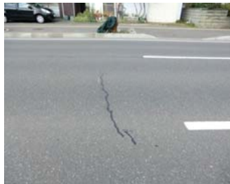
写真-1 ひびわれ箇所(H27 発生)
