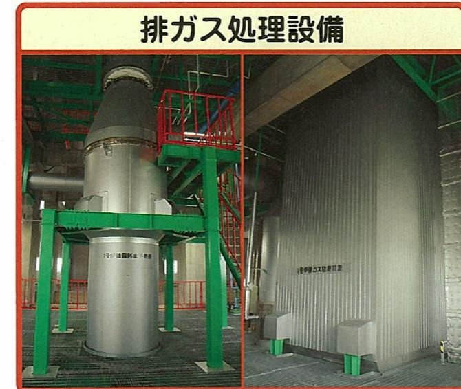
結露防止空気予熱器 排ガス除塵装置
