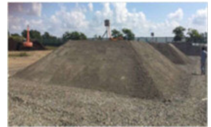
写真-2 アスファルト廃材・再生土混合
