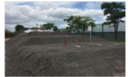
写真-1 アスファルト廃材盛土
