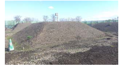
写真-2 アスファルト廃材・再生土混合盛土
