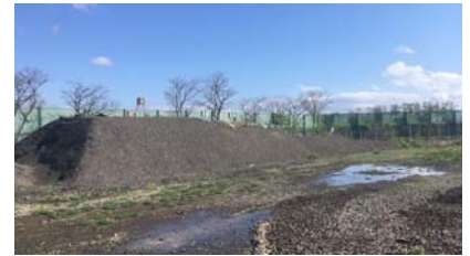
写真-1 アスファルト廃材盛土
