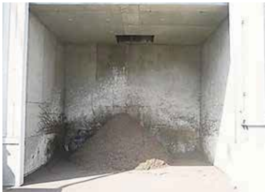
写真-39 脱水汚泥部（ふるい下）
