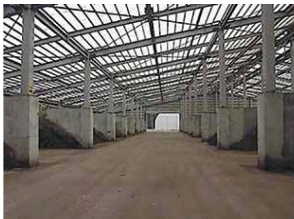
写真－2 堆肥化施設の内部
