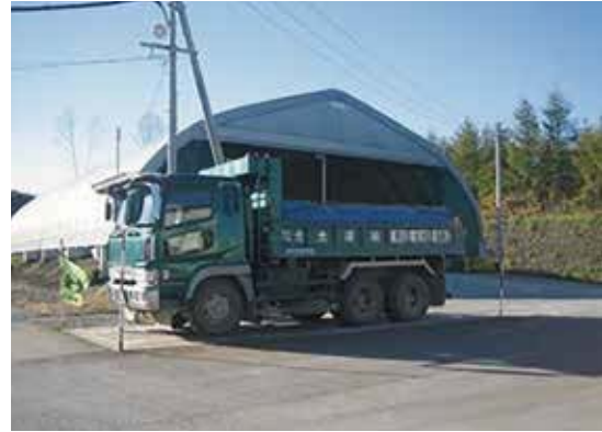
写真-44 最終処分 計量状況
