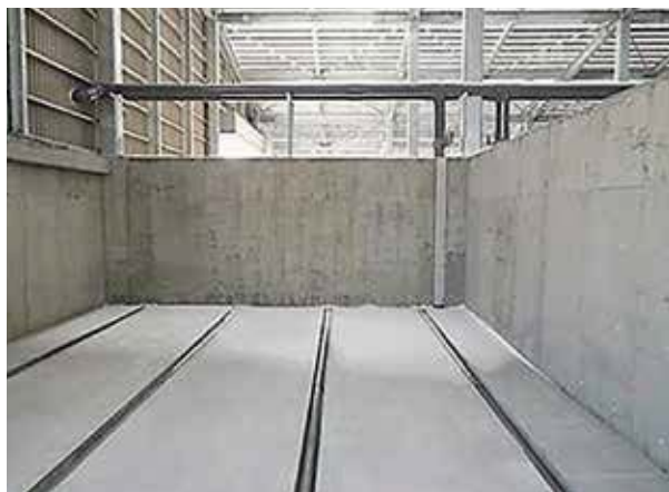
写真-11 ブロワ槽
