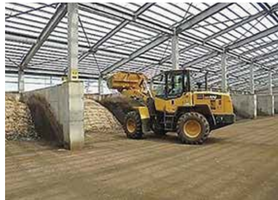
写真-24 高圧通気槽堆積状況
