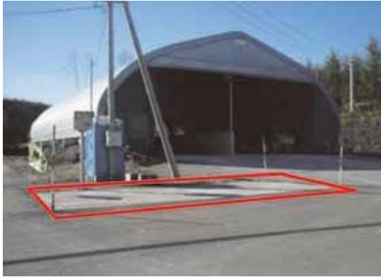
写真-43 計量装置全景（赤枠内）
