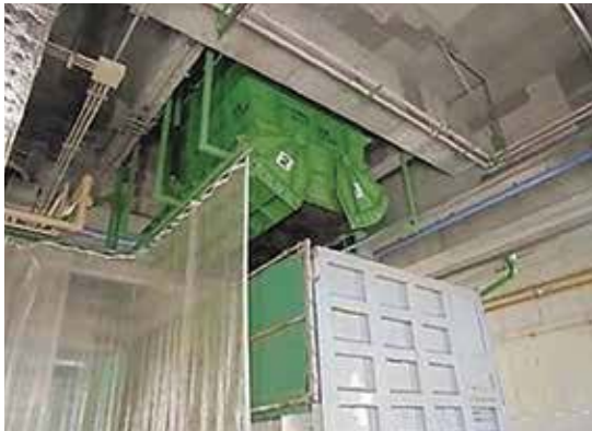
写真-17 脱水汚泥の積込状況
