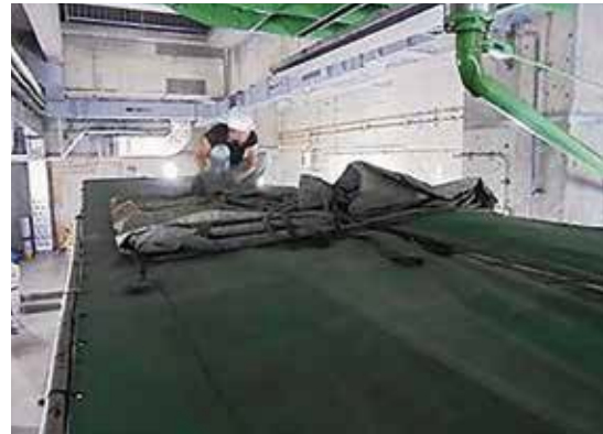
写真-18 防水シート取付状況
