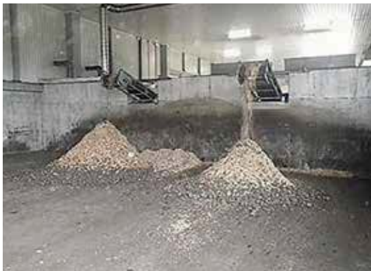
写真-23 混合物搬送状況 2
