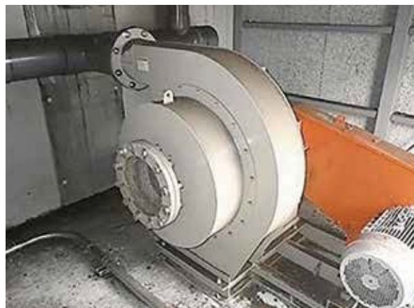
写真-12 ブロワ 15 kW
