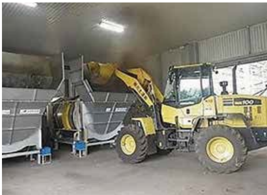
写真-21 混合装置への投入状況
