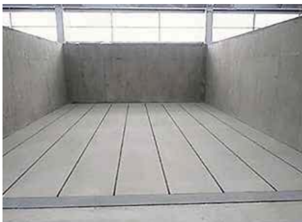
写真-9 高圧通気槽
