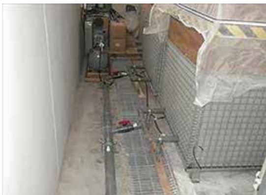
写真-9 テスト槽外通気部配管
