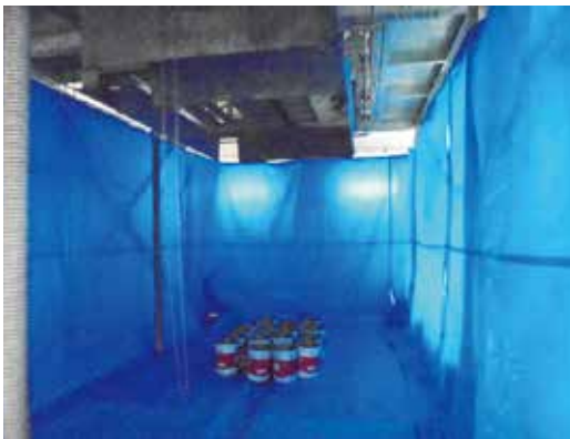
写真-12 汚泥回収時の養生
