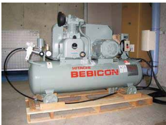
写真－5 コンプレッサー（1.5kW：3相200V）および高圧通気用の微細ノズル
