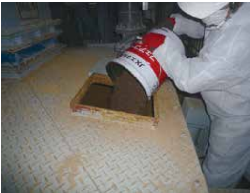
写真-30 乾燥汚泥のホッパへの投入作業
