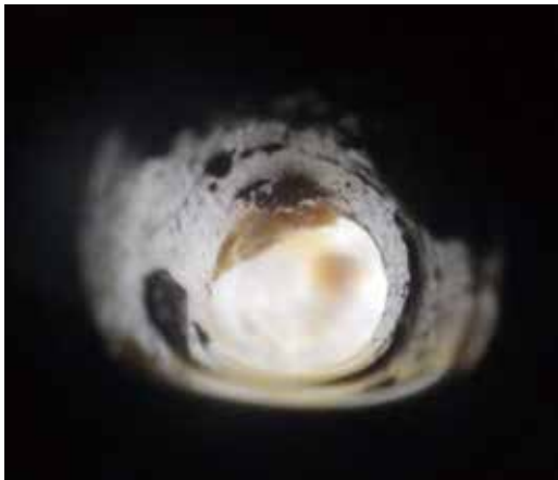
写真-10 ホース内部状況
