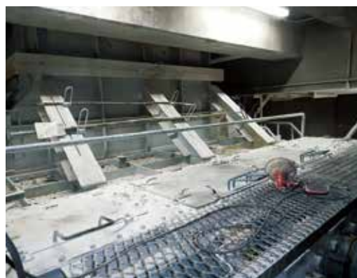
写真-2 脱水ケーキバンカ周辺
